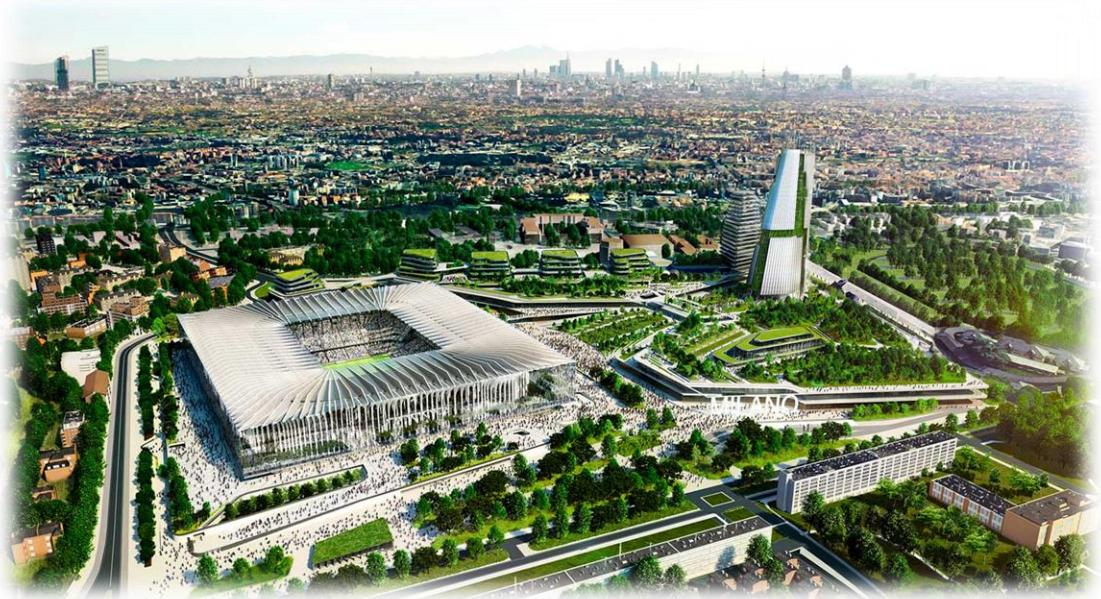
Consumo di suolo zero, perché ora lì c'è un parcheggio. Circondato da nove ettari di verde, pannelli fotovoltaici sulla copertura e di un sistema di raccolta dell'acqua piovana. Spazi interni climatizzati a ventilazione naturale
